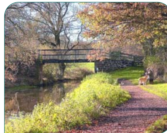
Warnicombe Bridge. Photo: N. S. Bathurst.
